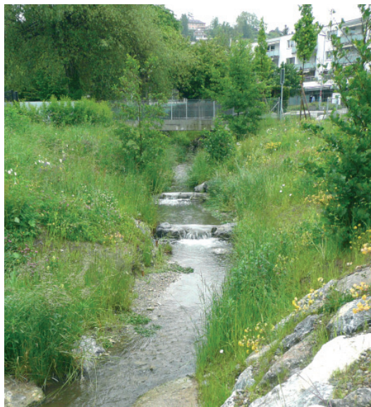
Die Böschungen wurden nicht humusiert und mit einer standortgerechten Wildblumenmischung angesät.
