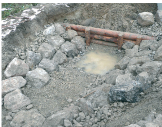
Die Schwellen wurden in kombinierter Bauweise mit Holz und Steinen erstellt.
