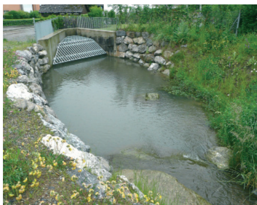
Der fertiggestellte Geschiebesammler mit neuem Rechen, um die Verklausungsgefahr zu reduzieren.
