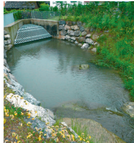
Der fertiggestellte Geschiebesammler mit neuem Rechen, um die Verklausungsgefahr zu reduzieren.
