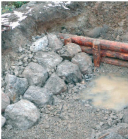
Die Schwellen wurden in kombinierter Bauweise mit Holz und Steinen erstellt.
