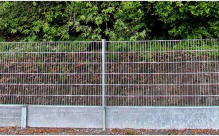
Amphibienleitwerk in Sargans: Der Eingang in den Durchlass, das Leitwerk zwischen Schützenhaus und Markthalle sowie das Leitelement in Kombination mit dem Zaun (von links im Uhrzeigersinn). Das Leitelement weist den Tieren den Weg zur Unterführung. Bilder: Susan Rupp
